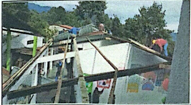
Foto 2: Desmontaje de lamina y tendales de madera a sustituir.
