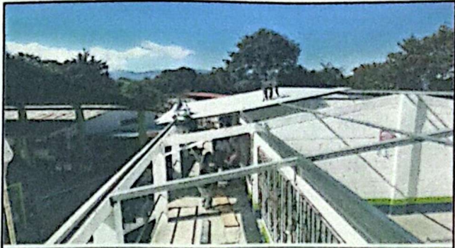
Foto 4: Instalacion de Lamina al modulo con estructura metalica.
