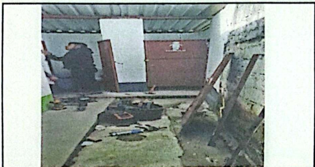
Foto 5: Sustitucion de la puerta de 1 sanitario .
