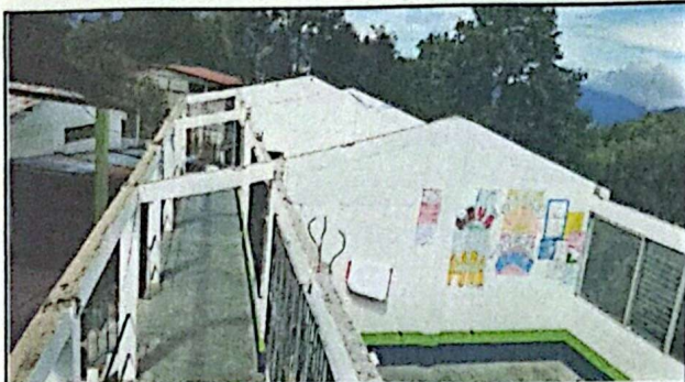
Foto 3: Modulo sin lamina, listo para la sustitucion de lamina troquelada calibre 26 con estructura metalica.
