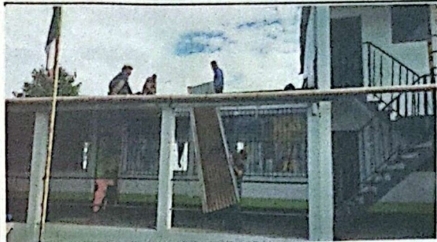
Foto1: Desmontaje de lamina del modulo a sustituir.
